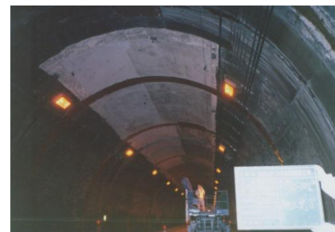
トンネル覆工コンクリートの中性化補修例
