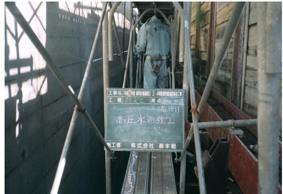
吹付けガンによる主材吹付
