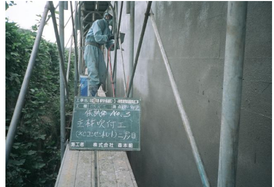
吹付けガンによる主材吹付
